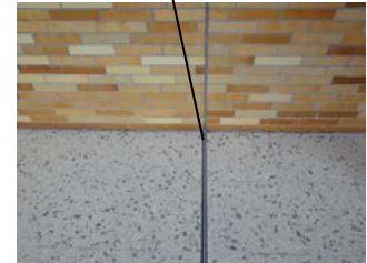
PCB-haltige Fugendichtungsmassen, außen und innen
