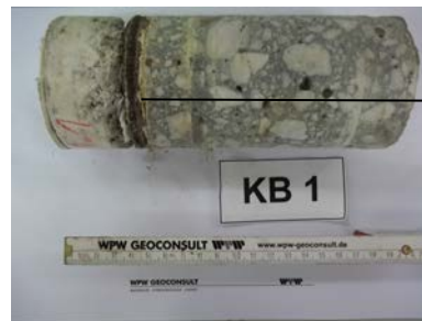
PAK-haltige Feuchtigkeitssperren unter dem Estrich
