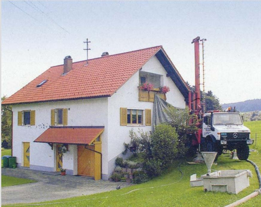
Bohrarbeiten für eine Erdwärmesonde (EWS) an einem Einfamilienhaus
